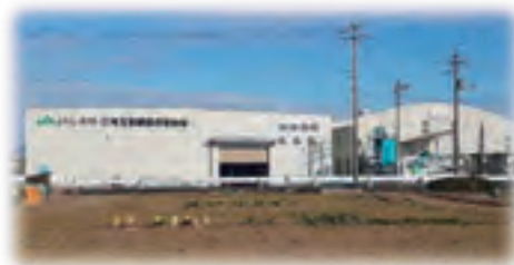
広域玉葱調製保管施設
