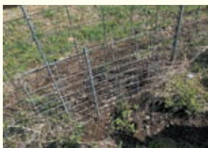
破損した箇所を修繕した柵
