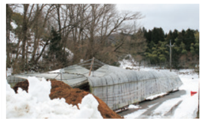
倒壊したビニールハウス
