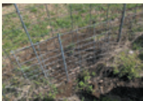
破損した箇所を修繕した柵
