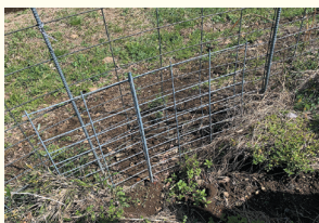
破損した箇所を修繕した柵
