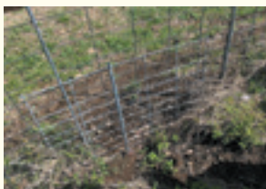
破損した箇所を修繕した柵
