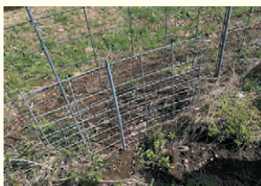
破損した箇所を修繕した柵
