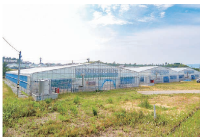
JAのリースハウス事業を活用して約10aのハウス3棟で栽培をおこなっている。桑原さんのハウスは写真奥の2棟と、離れた場所にもう1棟ある。
