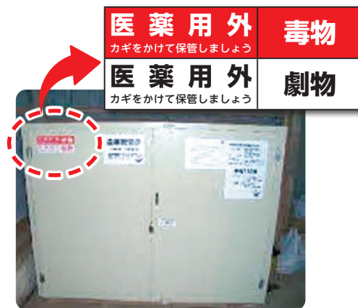
保管庫は、引火しにくい材質で施錠ができるもの すぐわかる場所に毒劇物の提示をする
