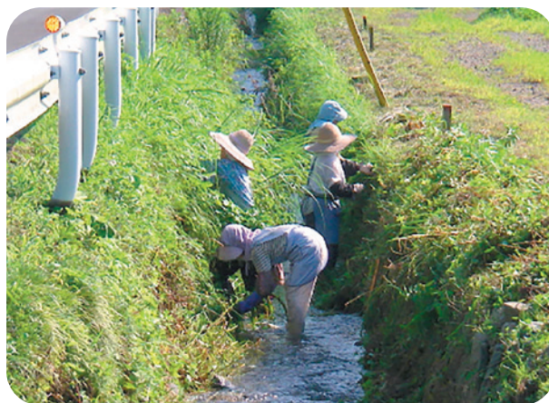
水路清掃の様子
