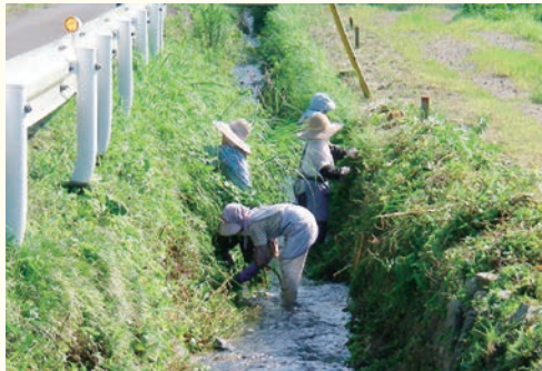
水路清掃の様子
