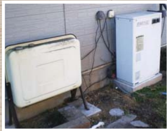
灯油ボイラー
