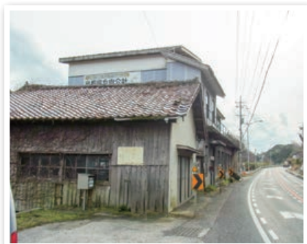
当時の朝山農協の本所として建てられ、国道9号から入る事務所は2階でした。屋上には、防災行政無線スピーカーも設置されていました
