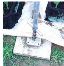
中柱補強対策の状況(福井県HPより)
