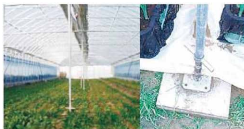
中柱補強対策の状況(福井県HPより)
